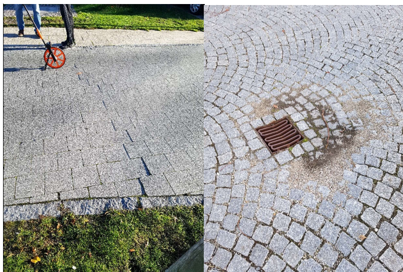
Figur 2.5 - Tværgående sætning i hævet flade. Lokal sætning omkring nedløbsbrønd.
